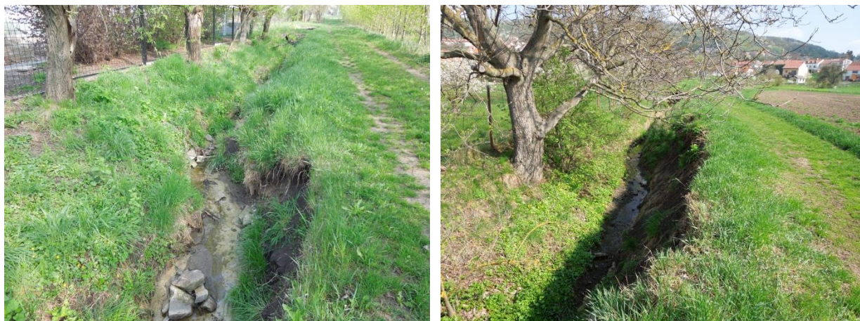
Obr. 2 Místa břehových nátrží v trase otevřeného koryta příkopu
